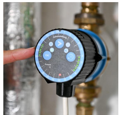
Abbildung 2: Moderne Zirkulationspumpe. Die grünen Lämpchen zeigen die Betriebszeit an.
