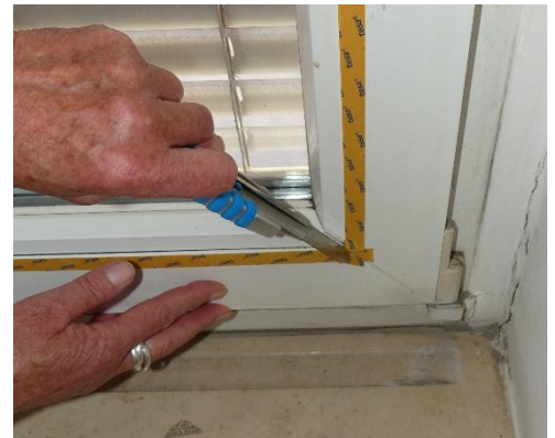
Abbildung 4: Überlappende doppelseitige Klebestreifen durchschneiden.
