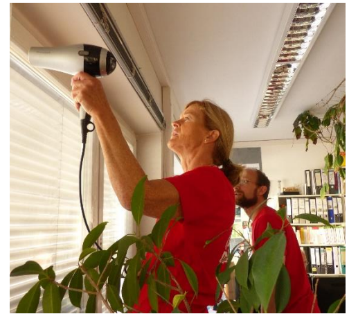
Abbildung 6: Durch das Föhnen strafft sich die Folie.
