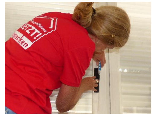
Abbildung 7: Überstehende Folie abschneiden.
