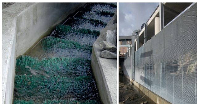
Abbildung 2: Beispiel eines Borstenfischpasses (Quelle: © Hydro-Energie Roth GmbH). Abbildung 3: Horizontal-Leitrechen nach Gluch im trockengelegten Staubereich einer Wasserkraftanlage (Quelle: Dr. Roland Steinhoff)
