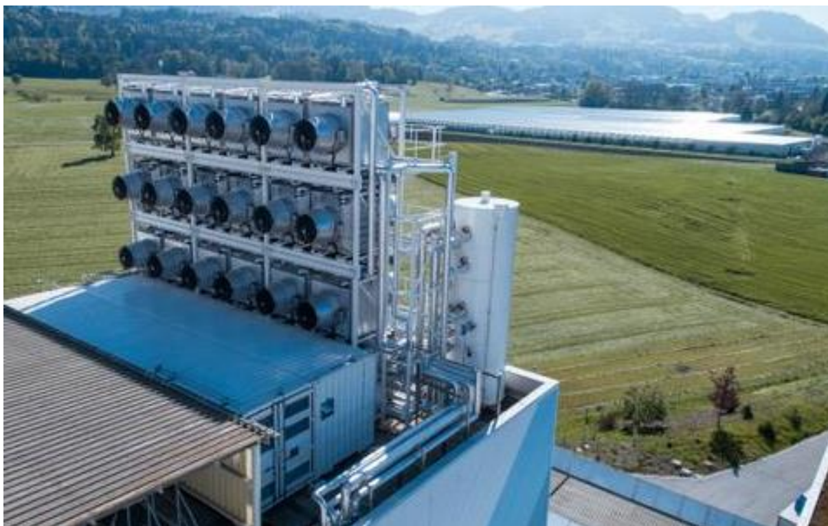
Abbildung 2: Anlage von Climeworks zur Gewinnung von CO 2 aus der Atmosphäre in Hinwil. Copyright Climeworks
