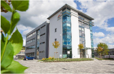
«Brennstoffzelle bei den Stadtwerken Herborn ©»
